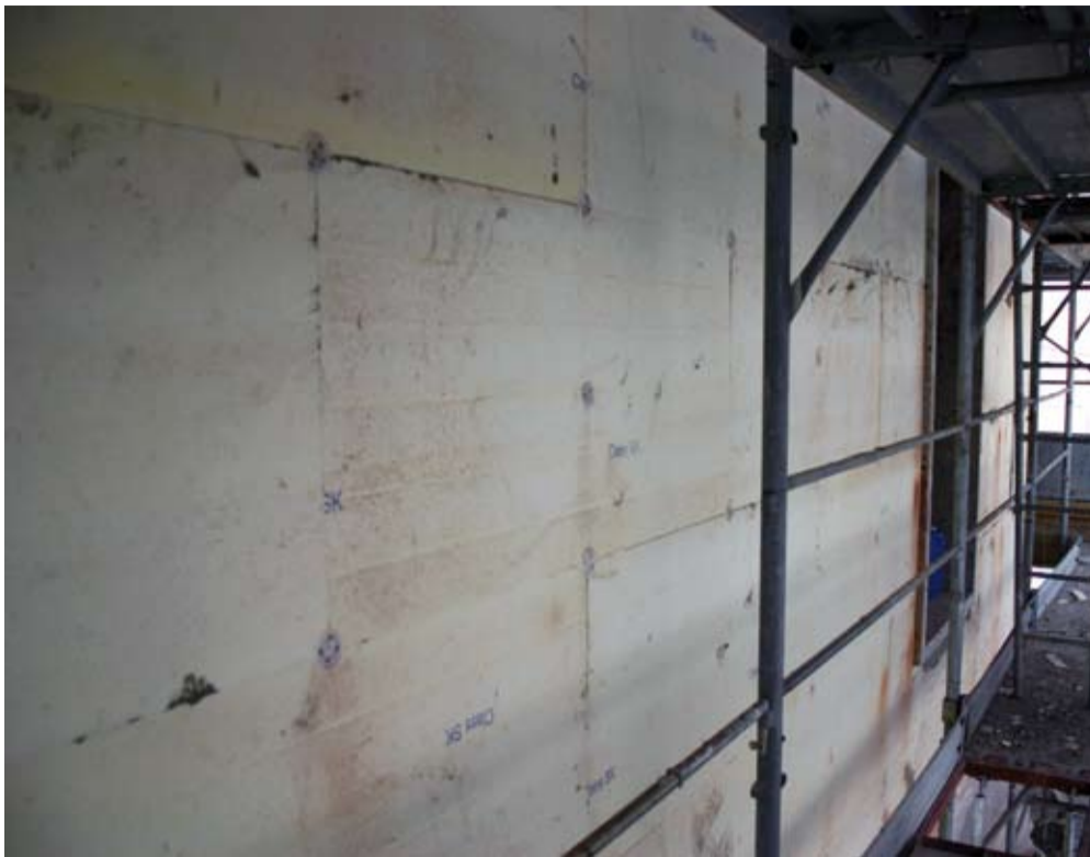
▲ Per l'isolamento a cappotto dell'edificio è stato scelto un pannello isolante ad alta densità.
