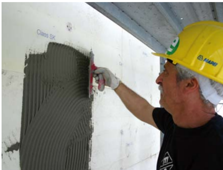
▲ Vsui pannelli isonati viene steso un primo strato di malta, e successivamente viene posizionata la rete in fibra di vetro come armatura.
