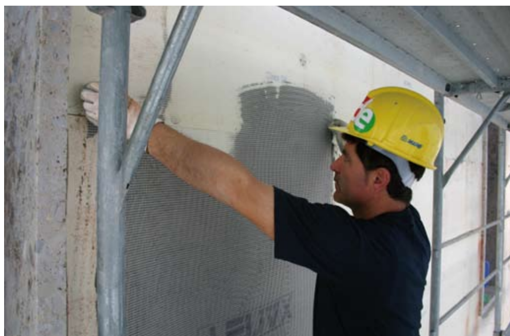
▲ Vsui pannelli isonati viene steso un primo strato di malta, e successivamente viene posizionata la rete in fibra di vetro come armatura.
