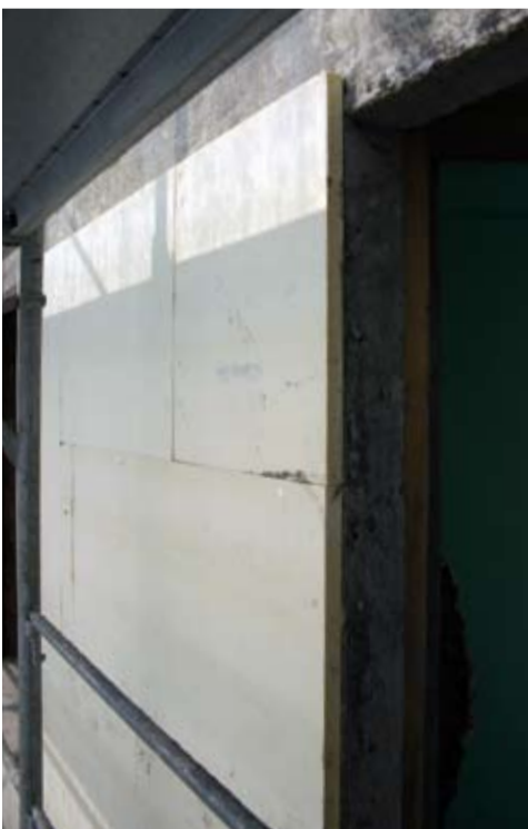
▼ Posa dei pannelli isolanti lungo tutto il perimetro, e applicazione dello strato di malta sui pannelli.
