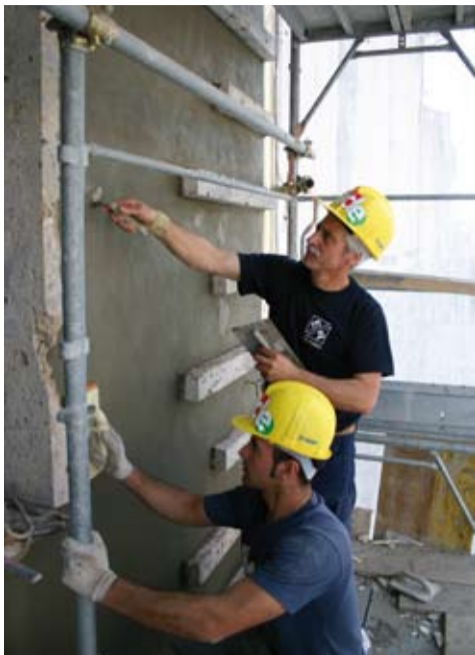
▲ Il sistema di isolamento a cappotto viene completato con l'applicazione della malta di finitura, facendo attenzione al rispetto degli elementi architettonici esistenti.
