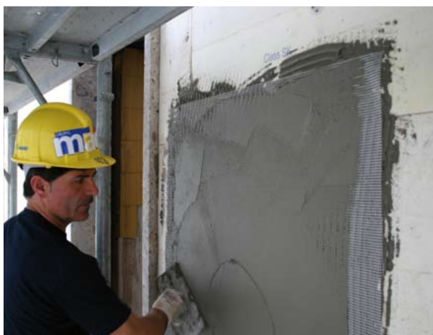
▲ Vsui pannelli isonati viene steso un primo strato di malta, e successivamente viene posizionata la rete in fibra di vetro come armatura.
