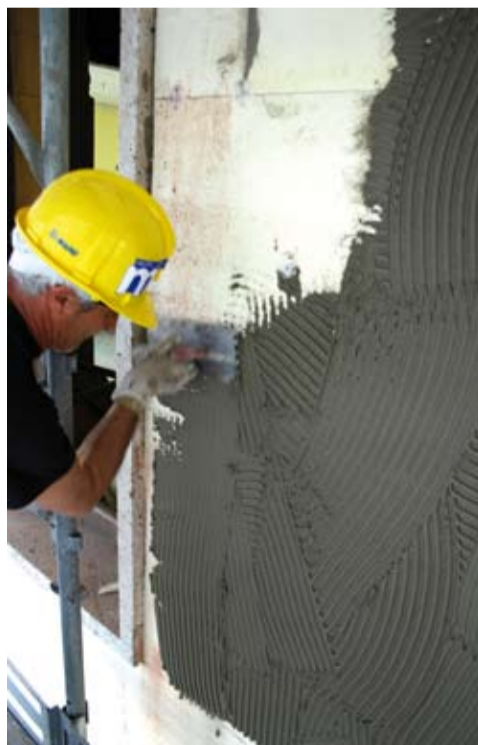
▼ Posa dei pannelli isolanti lungo tutto il perimetro, e applicazione dello strato di malta sui pannelli.
