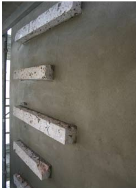
▲ Il sistema di isolamento a cappotto viene completato con l'applicazione della malta di finitura, facendo attenzione al rispetto degli elementi architettonici esistenti.
