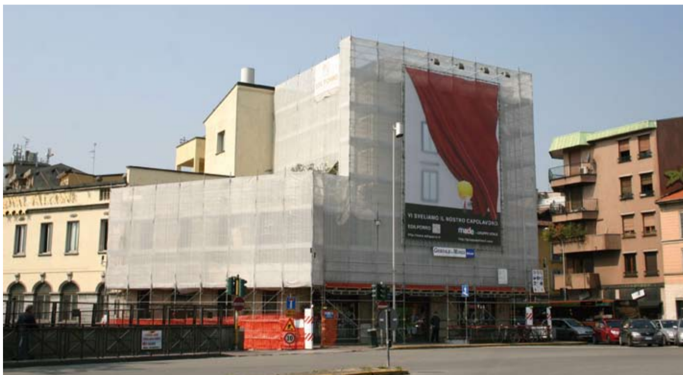
▲ Vista del cantiere dalla piazza; in evidenza il grande tabellone sponsorizzato "Made".
