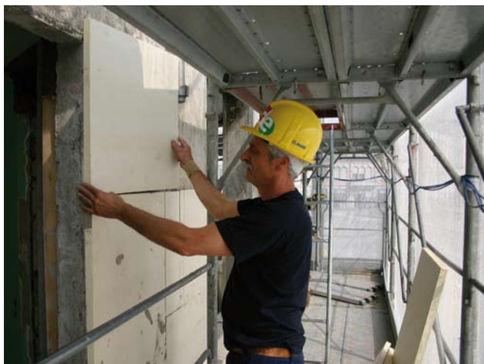
▼ Applicazione dei pannelli isolanti sulla muratura.
