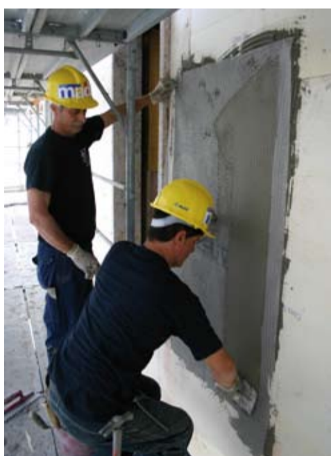
▲ Applicazione dello strato di rasatura sul paramento costituito dai pannelli isolanti.
